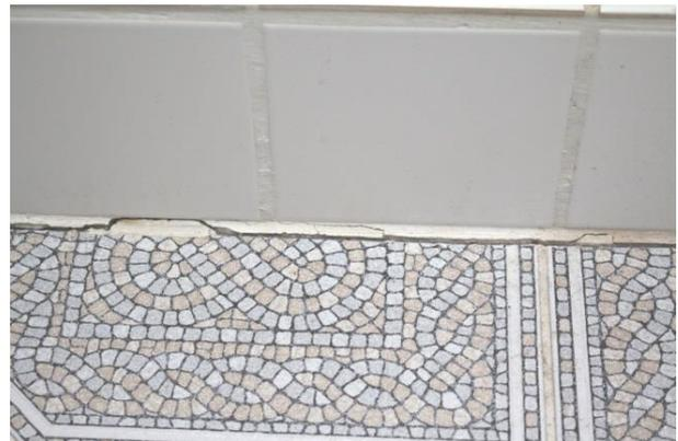
Bild 3: Diese Fuge im Bad ist nicht mehr dicht. Von hier kann Wasser in das Bauwerk gelangen. In diesem Fall führte es zum Pilzbefall der darunter liegenden Holzkonstruktion.
